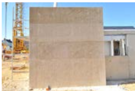
▲ Mise en oeuvre béton de site
