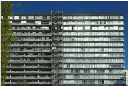
▲ Pendant les travaux
