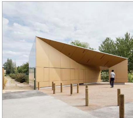
▲ Façade nord-ouest - coté esplanade - fermée
