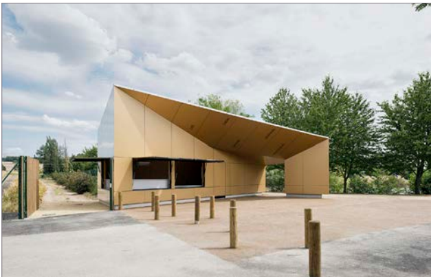
▲ Façade nord-ouest - coté esplanade - ouverte
