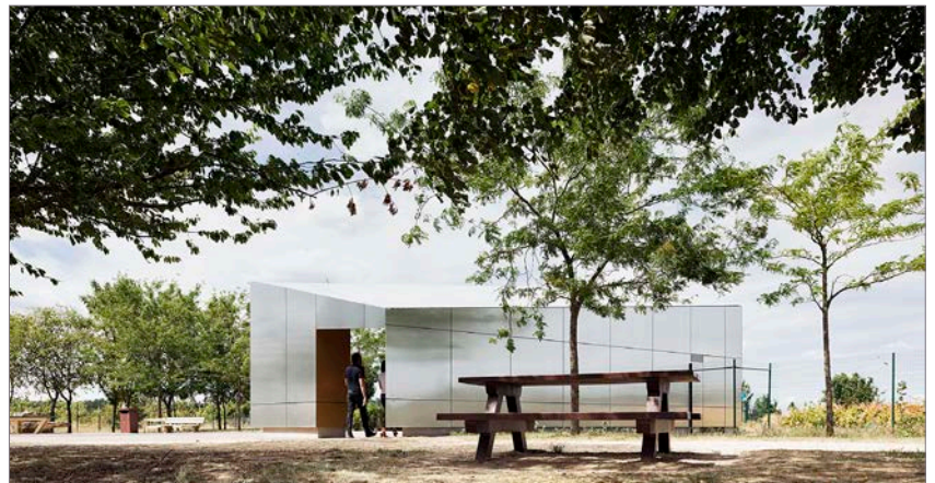
▲ Façade sud-est - coté lac
