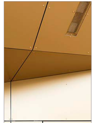
▲ Détail bardage alucobond couleur or brossé
