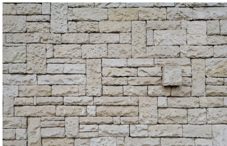
▲ Détail d'une façade recouverte de moellons
