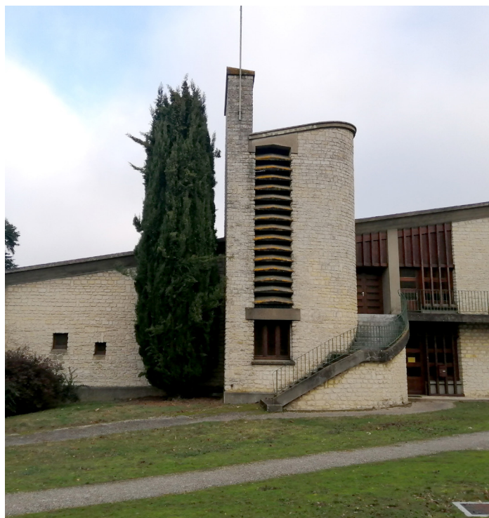
▲ Clocher latéral entouré d'un escalier circulaire
