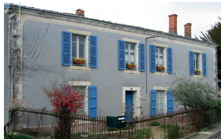
Maison dans le marais
