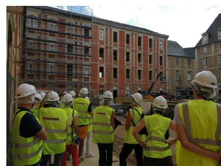
▲ © CAUE 86 - groupe en visite de chantier (extérieur)
