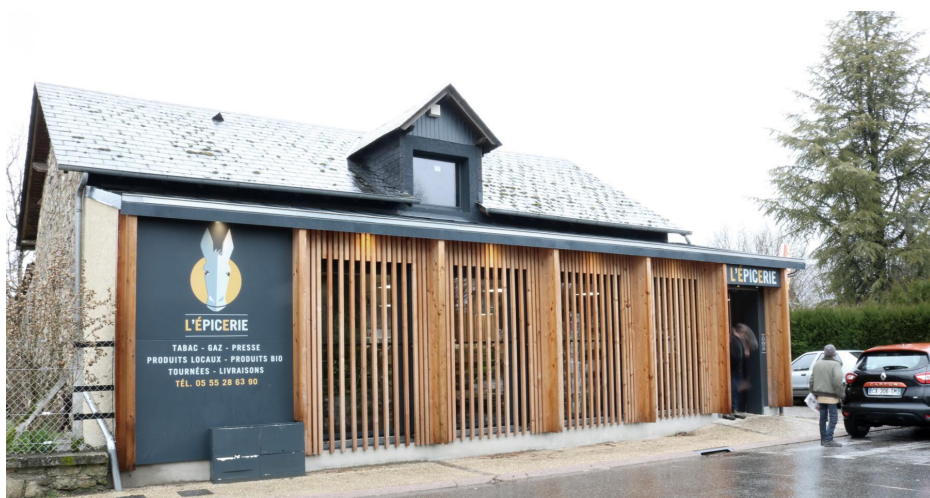
▲ Vue extérieure du bâtiment
