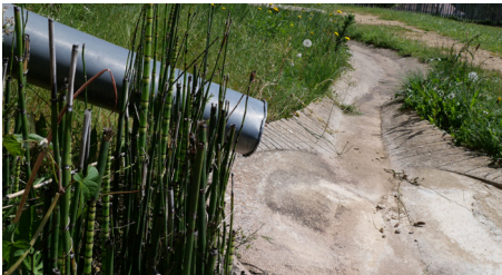
▲ Une gestion aérienne des eaux de pluies de toiture par des noues et des petits bassins d'infiltration.
