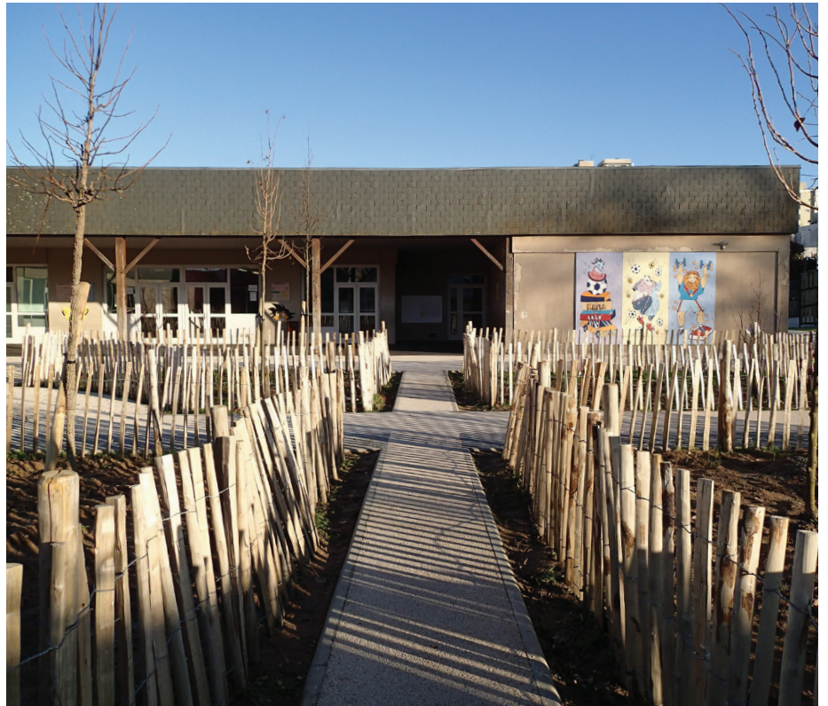
▲ Protection des espaces plantés par des ganivelles de châtaignier
