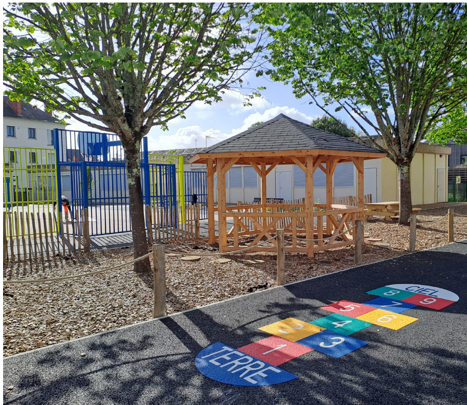
▲ Cour d'école après travaux
