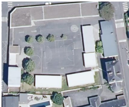
▲ Cour d'école minérale avant travaux
