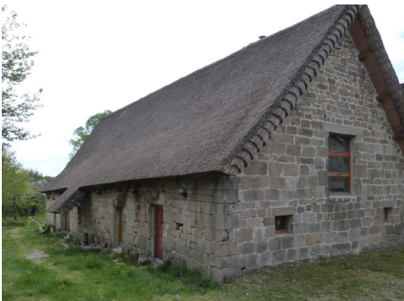
▲ Vue après travaux
