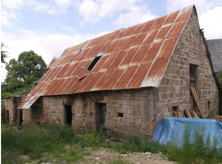
▲ Vue avant travaux
