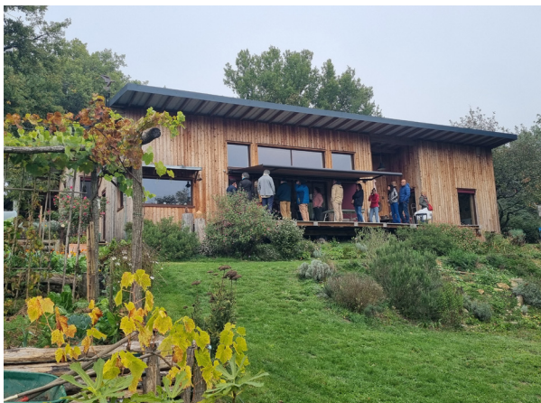
▲ ©CAUE 86 - groupe de visiteurs sur la terrasse
