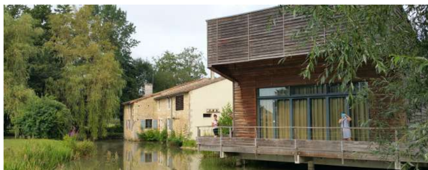
Réhabilitation des bâtiments en pierre et construction en bois - Crédit photo - CAUE 79
