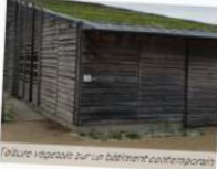
Réhabilitation d'un bâtiment contemporain - Crédit photo : CAUE 79
