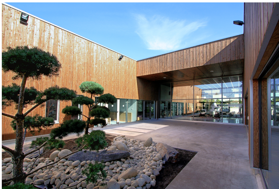
▲ En haut, vue générale de la façade d'entrée au nord après les travaux ©HPL Architectes Ci-dessus, vue sur un des deux patios ©HPL Architectes
