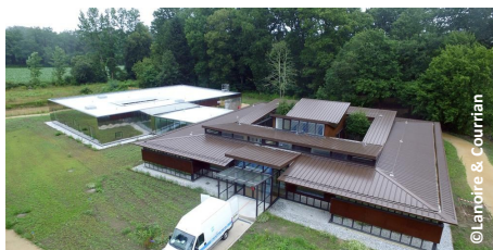
▲ La médiathèque vue de haut
