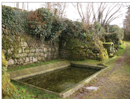
Ensemble hydraulique, commune de Savennes
