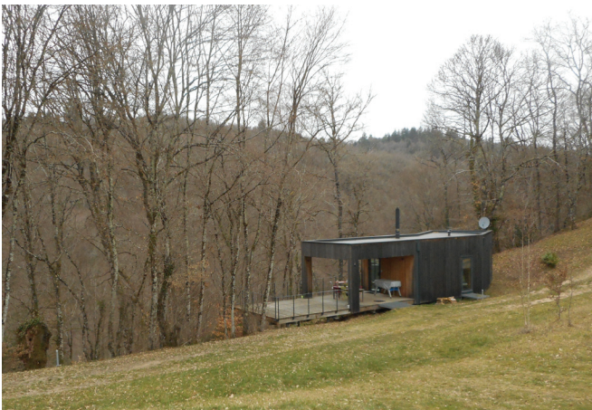
▲ Le stationnement est organisé dans la prairie, cependant un chemin permet une accessibilité PMR à l'un des logements. On perçoit en premier le bâtiment d'accueil.
