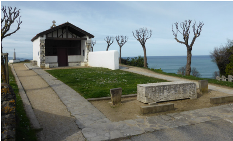
▲ Un aménagement soigné, qui fait la part belle aux surfaces perméables.
