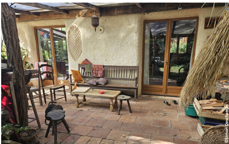
▲ Sol terrasse en matériaux de récupération, enduit terre sur la façade
