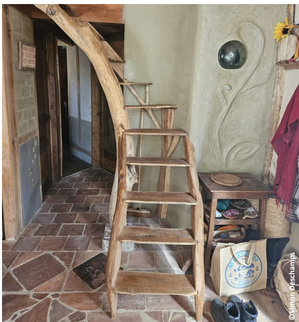
▲ Le sol en tomettes récupérées et l'escalier réalisé avec l'arbre existant
