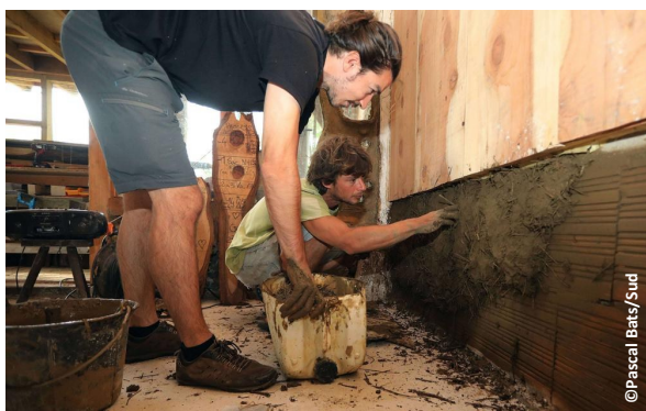
▲ Réalisation du corps d'enduit en terre et paille
