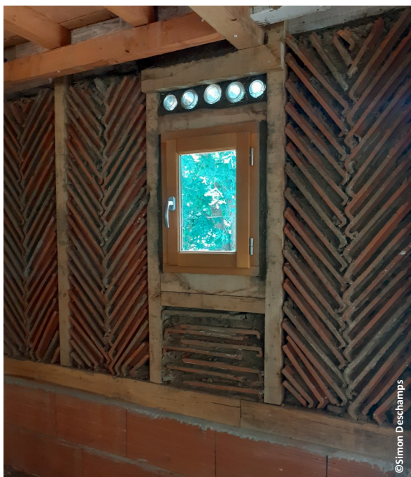
▲ Tuiles récupérées et intégrées dans les murs, culs de bouteilles en imposte
